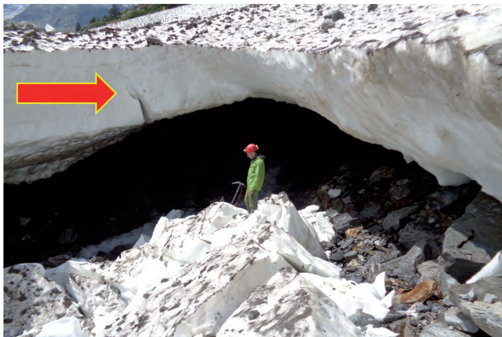
Galleria di contatto: cedimento a flessione della volta. Si notino a valle i resti della volta già crollata.
